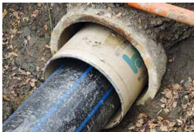
Rury osłonowe wodociągu w Karwinie we wschodnich Czechach. Instalacja wykonana metodą reliningu
