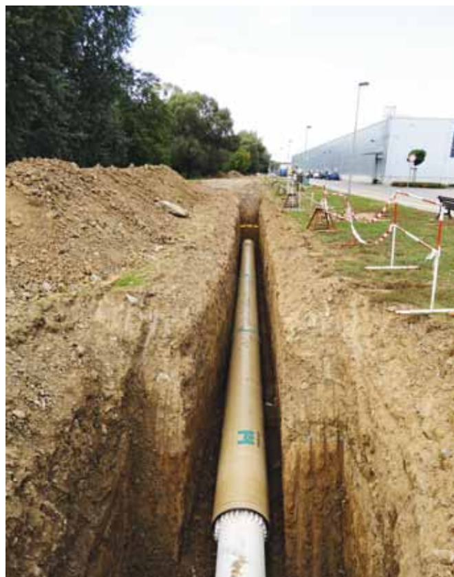
Rury osłonowe gazociągu w Brnie w Czechach. Instalacja wykonana metodą wykopu otwartego
