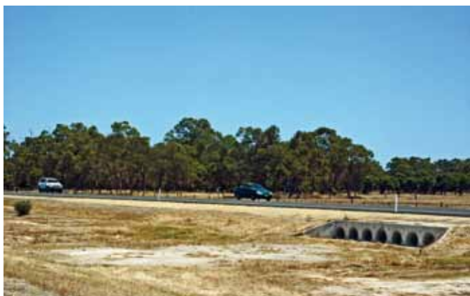
Ryc. 7. Przykład przepustu wielootworowego w zachodniej Australii jako sposobu na zwiększenie światła konstrukcji przepustu, fot. A. Wysokowski
