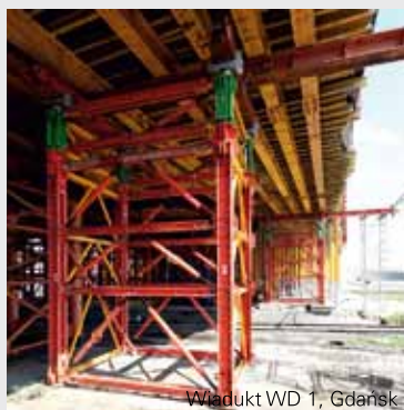
Wiadukt WD 1, Gdańsk
