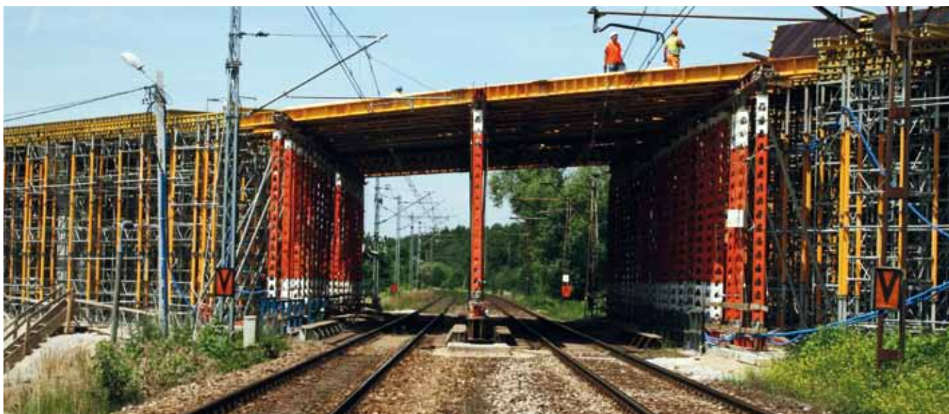
Ryc. 18. Rusztowanie podporowe nad torami kolejowymi – widok od strony Medyki
