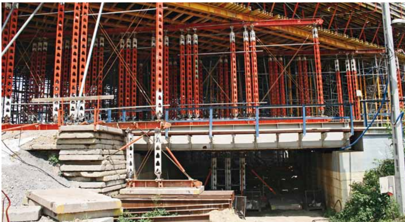
Ryc. 17. Rusztowanie podporowe nad torami kolejowymi – widok z boku
