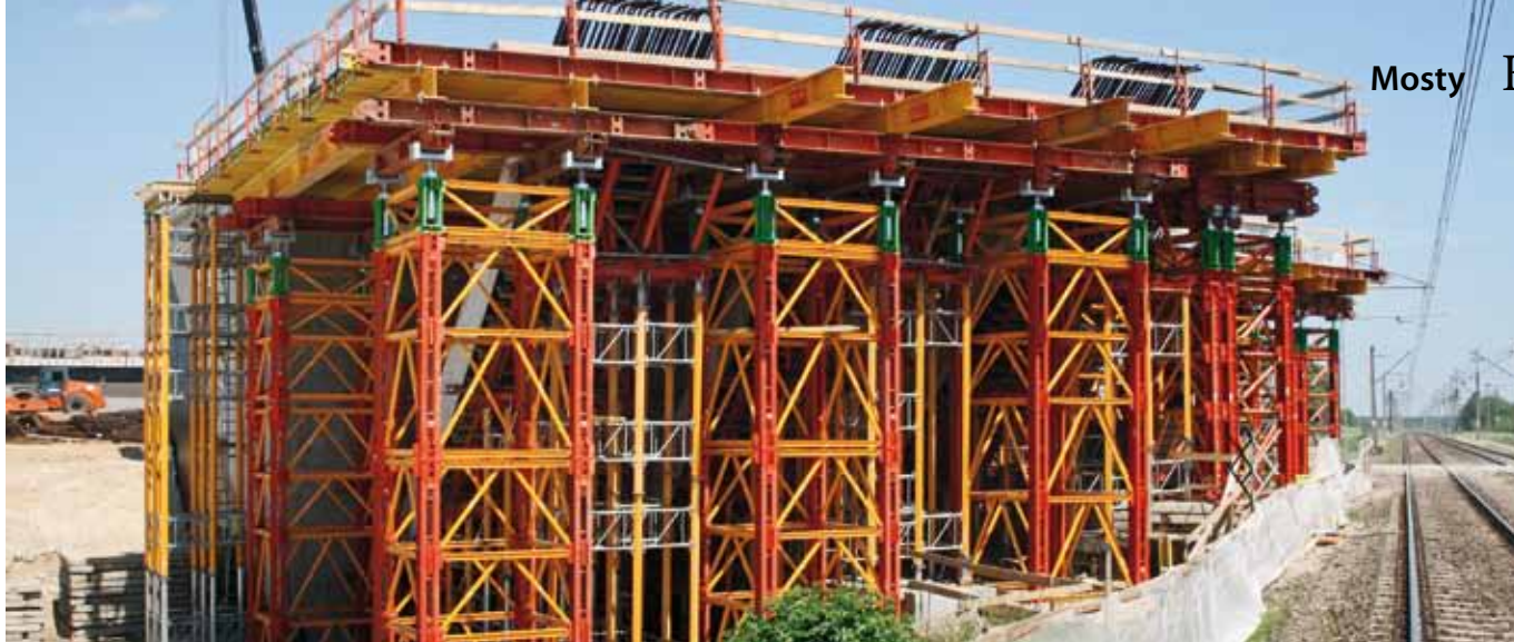
Ryc. 13. Rusztowania podporowe wiaduktu WA122 przed ułożeniem dźwigarów T24
