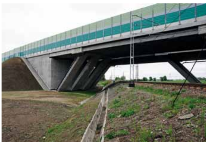
Ryc. 15. Ukończony i oddany do użytkowania wiadukt WA122
