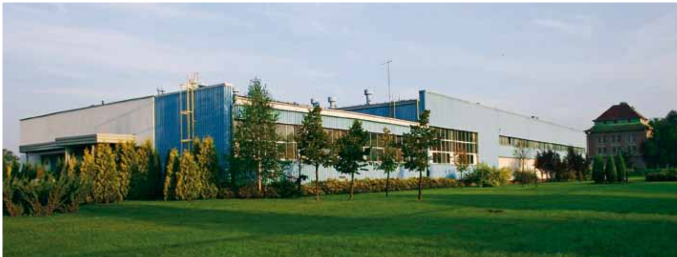
Zakład Uzdatniania Wody Prałkowce w Przemysłu
