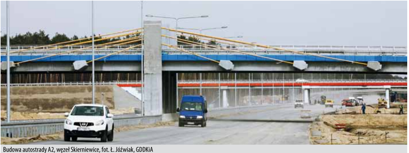
Budowa autostrady A2, węzeł Skierniewice, fot. Ł. Józwiak, GDDKiA
