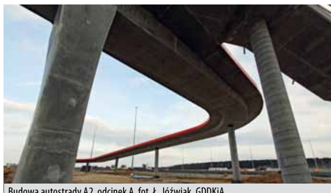
Budowa autostrady A2, odcinek A, fot. Ł. Józwiak, GDDKiA
