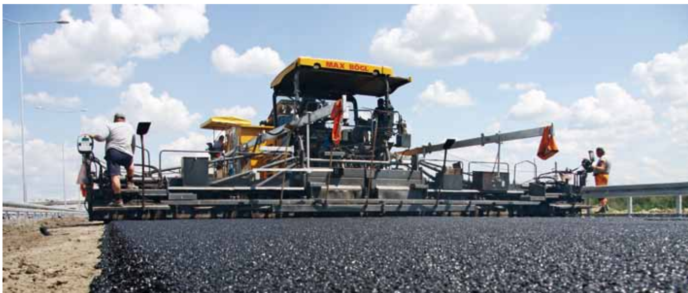
Nowoczesny rozścielacz do układania asfaltu na odcinku C, fot. Ł. Józwiak, GDDKiA
