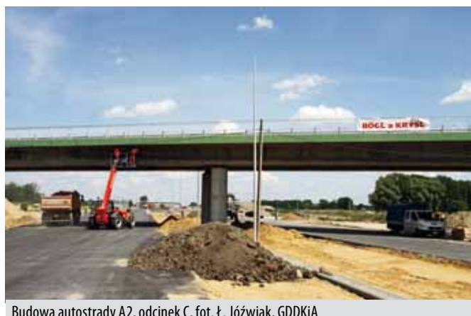
Budowa autostrady A2, odcinek C, fot. Ł. Józwiak, GDDKiA
