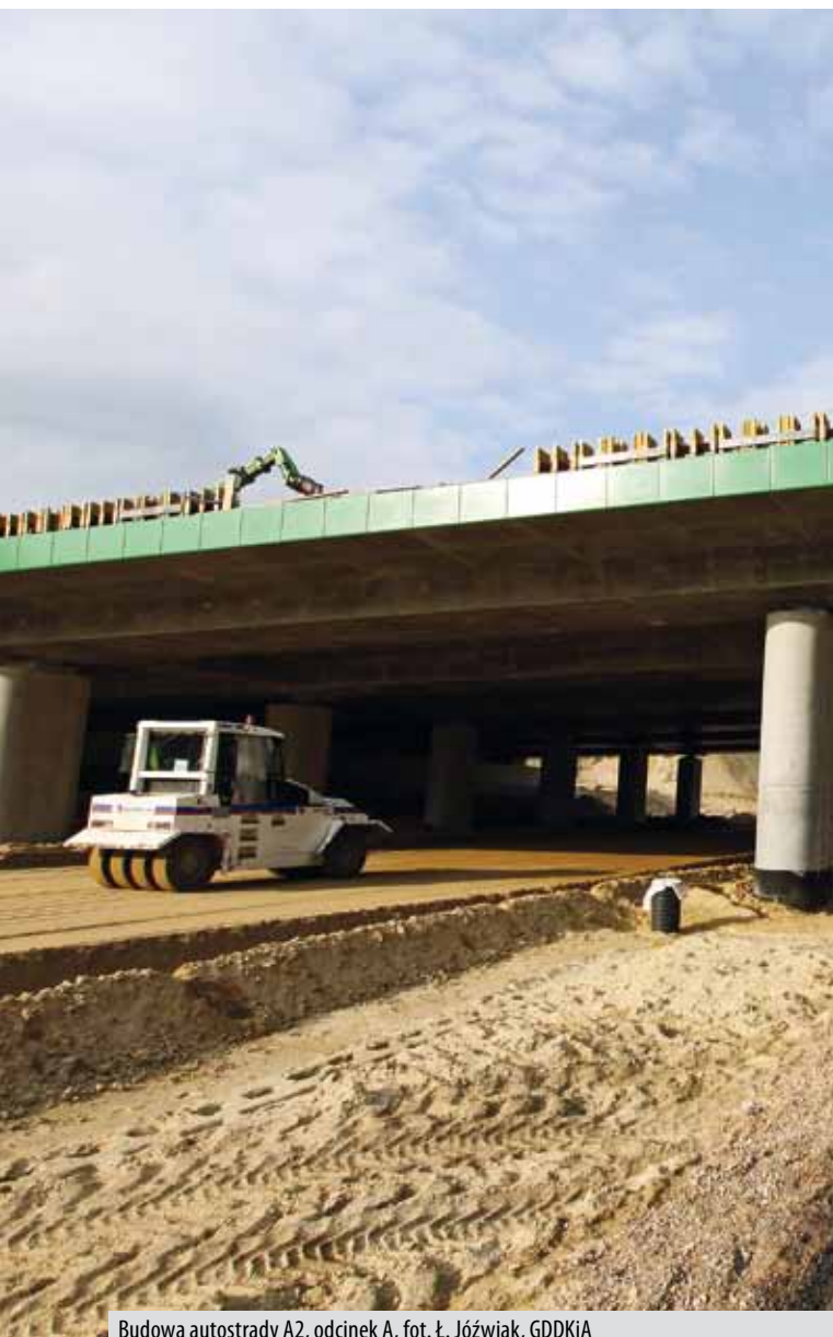
Budowa autostrady A2, odcinek A, fot. Ł. Józwiak, GDDKiA
