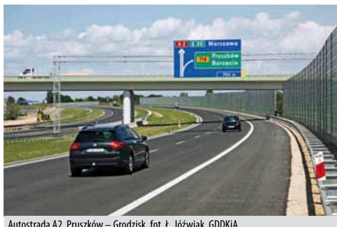
Autostrada A2, Pruszków – Grodzisk, fot. Ł. Józwiak, GDDKiA
