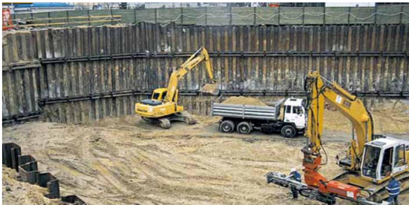
Wykop budowy zabezpieczony systemem BB DRILL
