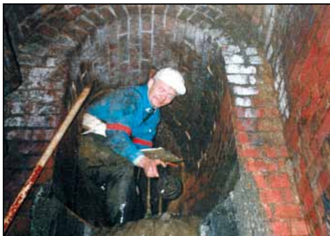
Ryszard Jurecki w kanale podczas przeglądu instalacji w Poznaniu.
