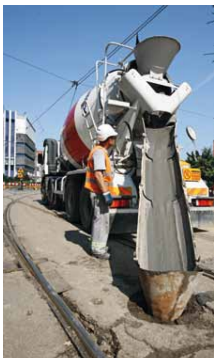
Zalwanie kanałów burzowych w Katowicach przy użyciu mieszanki wypełniającej GRUNTON®
