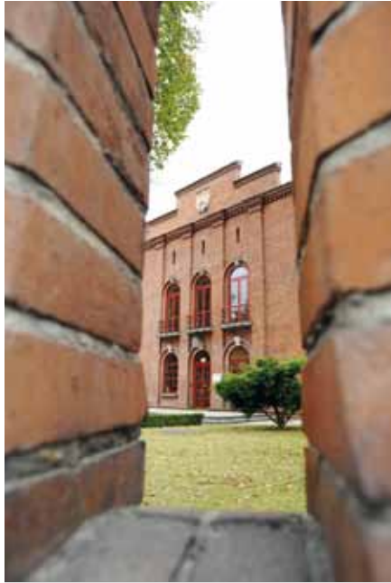
Zakład Uzdatniania Wody Bielany
