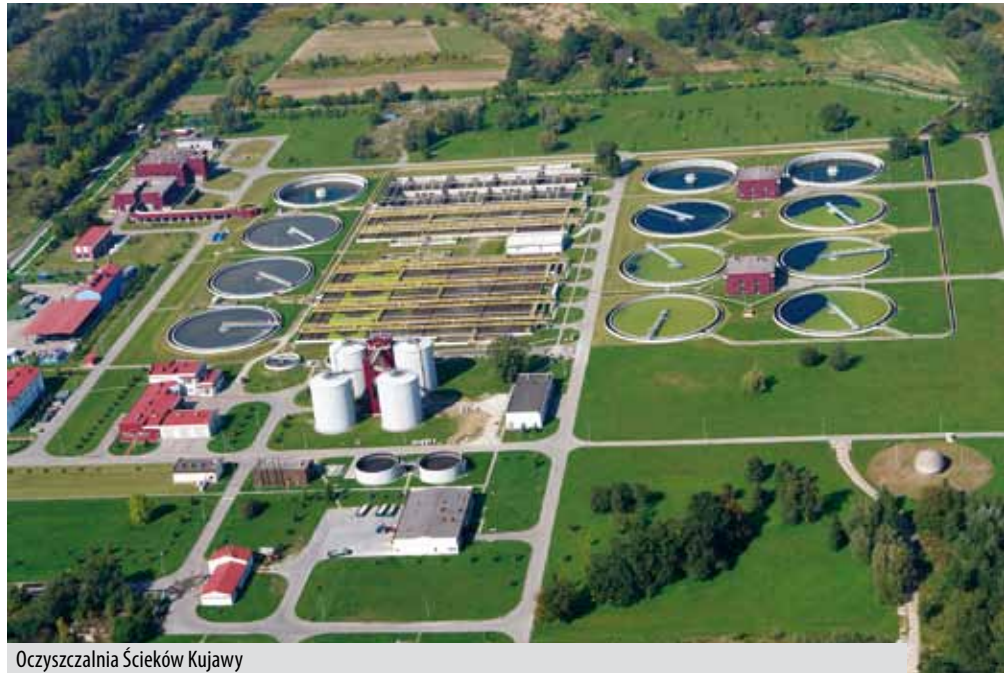
Oczyszczalnia Ścieków Kujawy
