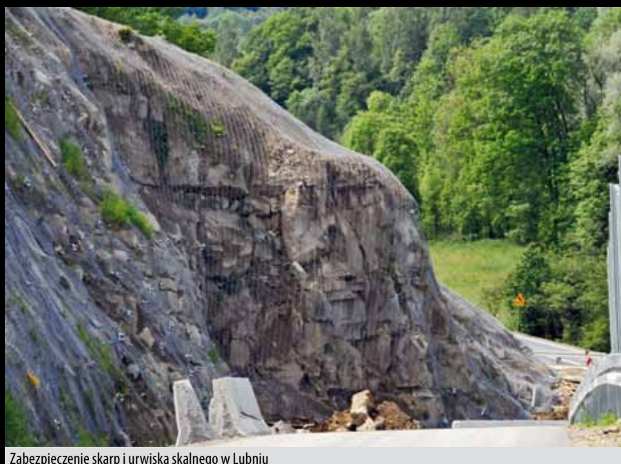
Zabezpieczenie skarp i urwiska skalnego w Lubniu
