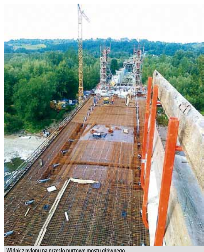
Widok z pylonu na przęsło nurtowe mostu głównego
