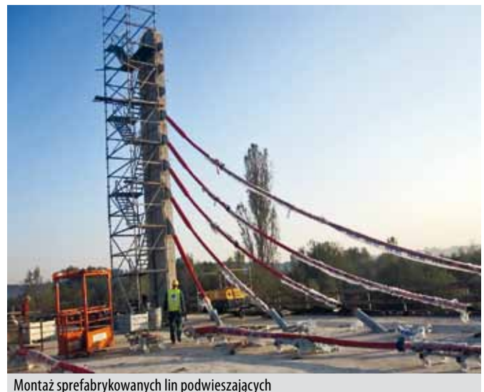
Montaż sprefabrykowanych lin podwieszających
