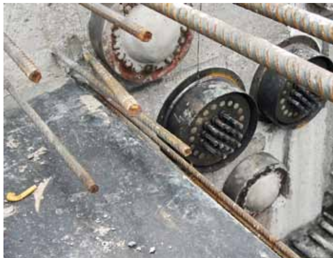
Zakończenie segmentu ED – łączniki ruchome w środku i bierne w czapkami iniektu
