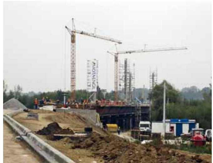
Widok na most główny od strony Dobczyc
