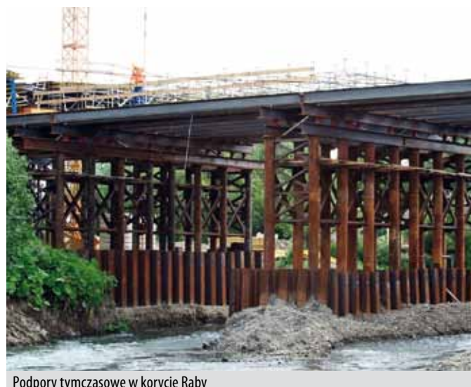
Podpory tymczasowe w korycie Raby
