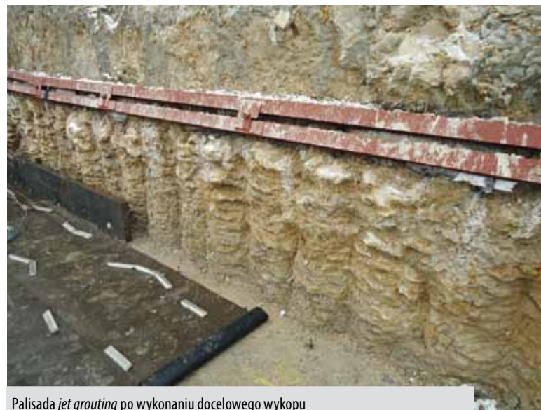
Palisada jet grouting po wykonaniu docelowego wykopu
