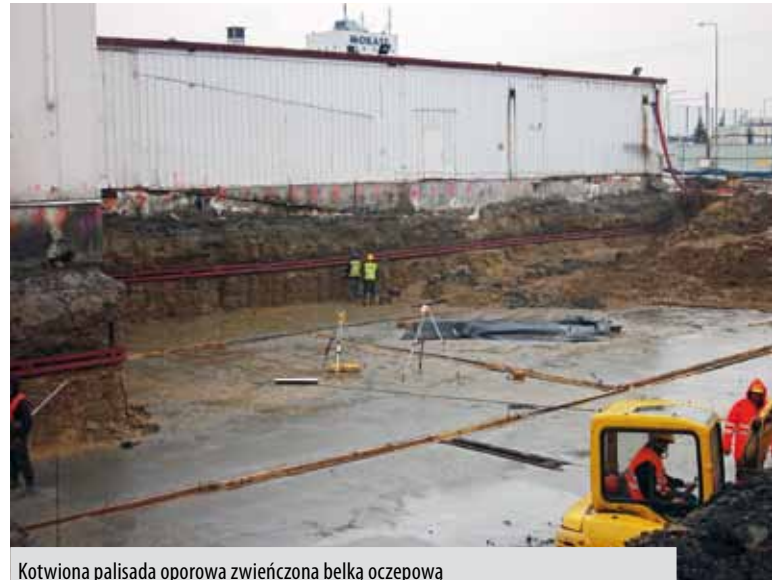
Kotwiona palisada oporowa zwieńczona belką oczepową
