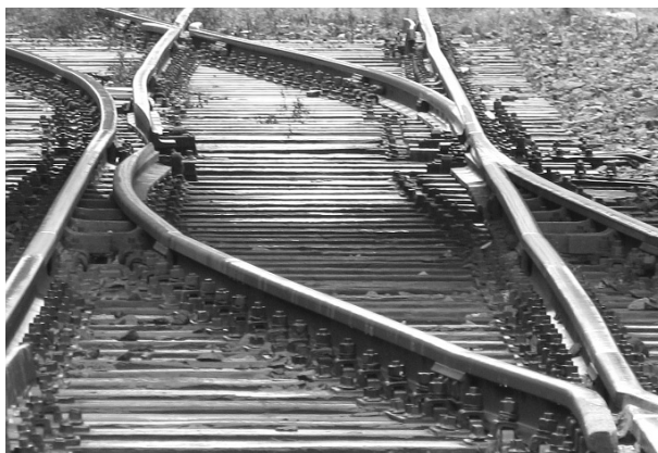
Rys. 16. Rozjazdy 49E1-190-1:9 ułożone bez wstawki prostej
