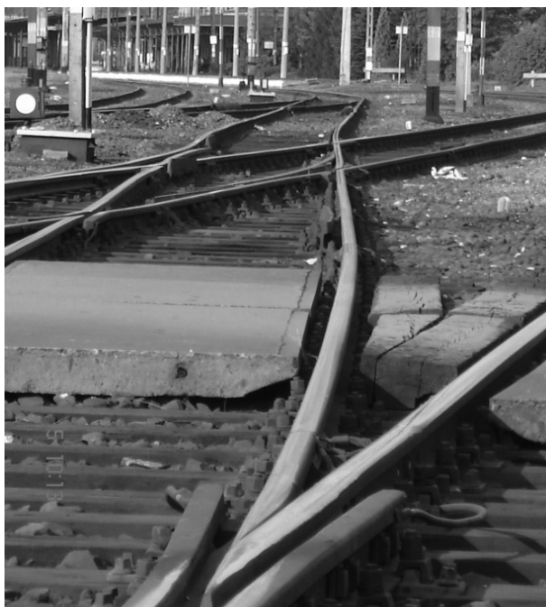
Rys. 6. Widok połączenia: na pierwszym planie krzyżownica rozjazdu S49-500-1:12 [fot. A. Krzyżański]
