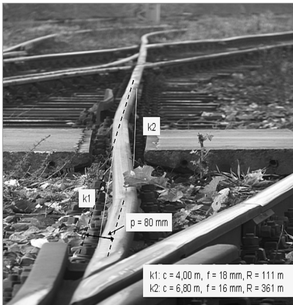
Rys. 2. Błąd spowodowany niewłaściwym położeniem punktu matematycznego [fot. A. Stachowiak]
