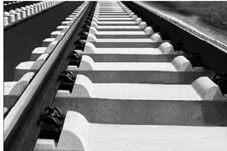
Rys. 9. Nawierzchnia typu GETRAC [7]
