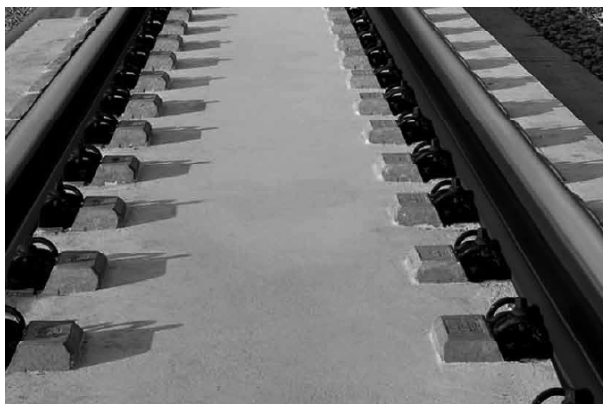
Rys. 11. Nawierzchnia typu RHEDA 2000 [19]
