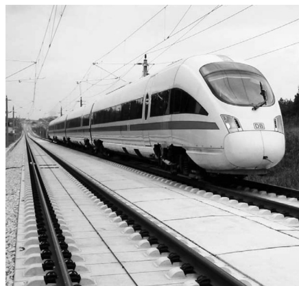
Rys. 7. Nawierzchnia z płyt prefabrykowanych Bögl: (a) konstrukcja: 1) warstwa mrozochronna, 2) warstwa stabilizowana hydraulicznie (grubość 0,3 m), 3) masa spoinowa (grubość 0,03 m), 4) płyta żelbetowa z betonu klasy C45/55, grubość 0,2 m, 5) dylatacja, 6) podparcie szyny, 7) urządzenie wyrównujące, 8) otwór na masę spoinową, 9) stal GEWI; (b) tory na linii ICE Norymberga – Ingolstadt [5]
