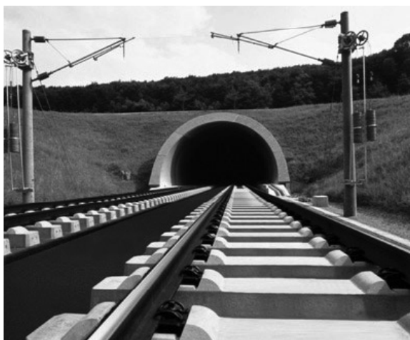
Rys. 9. Nawierzchnia GETRAC z systemem warstw asfaltowych na kolejach niemieckich
