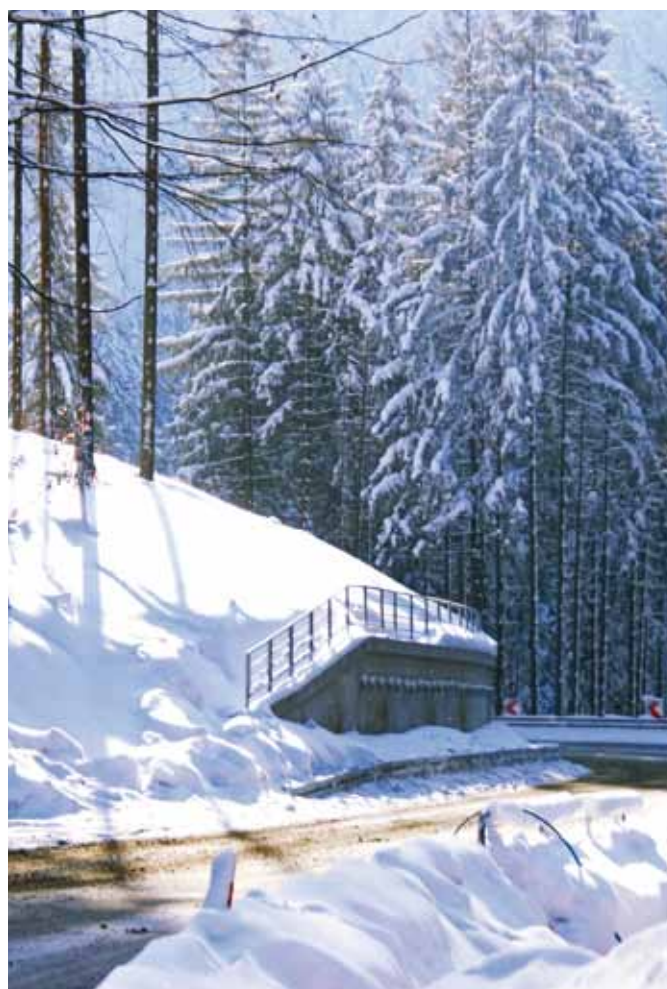
Zimowy widok na zabezpieczone osuwisko nr 2
