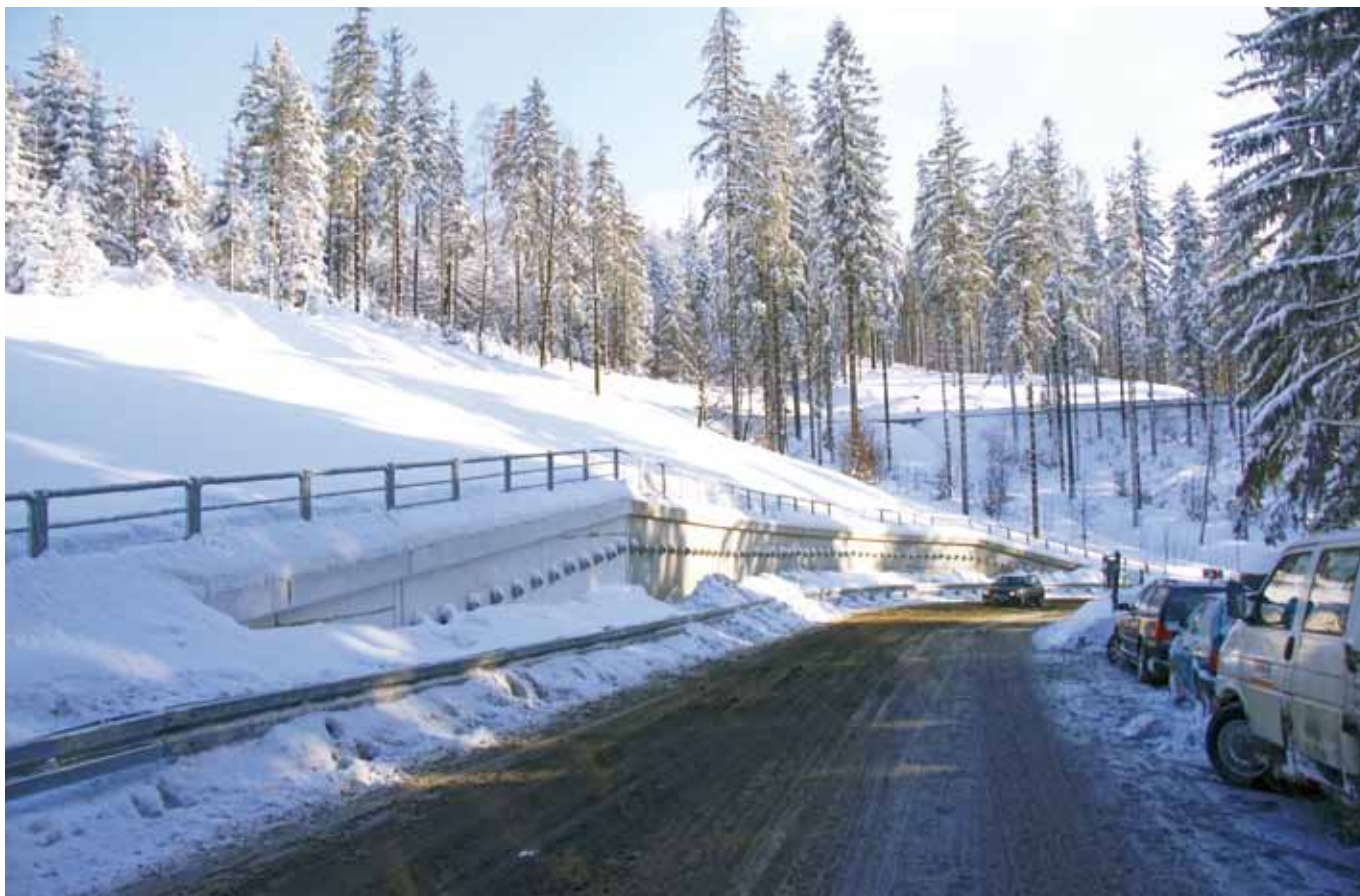
Zimowy widok na zabezpieczone osuwisko nr 1
