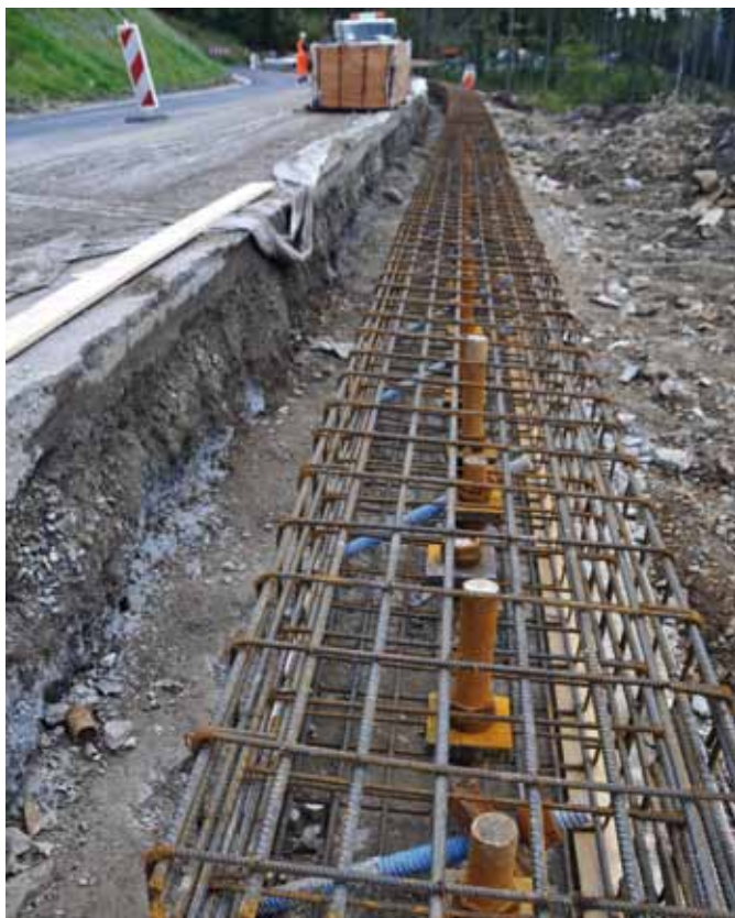
Osuwisko nr 1. Górna bariera mikropalowa
