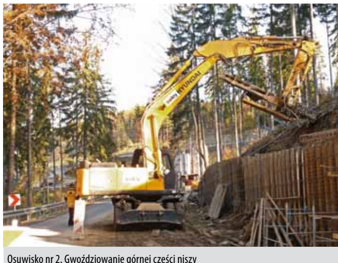
Osuwisko nr 2. Gwoździowanie górnej części niszy
