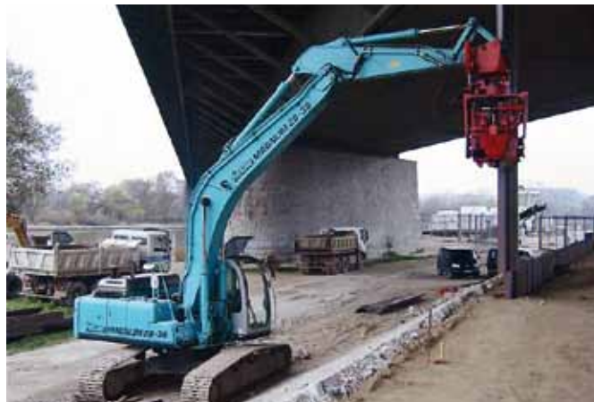
Wbijanie profili pod wiaduktem
