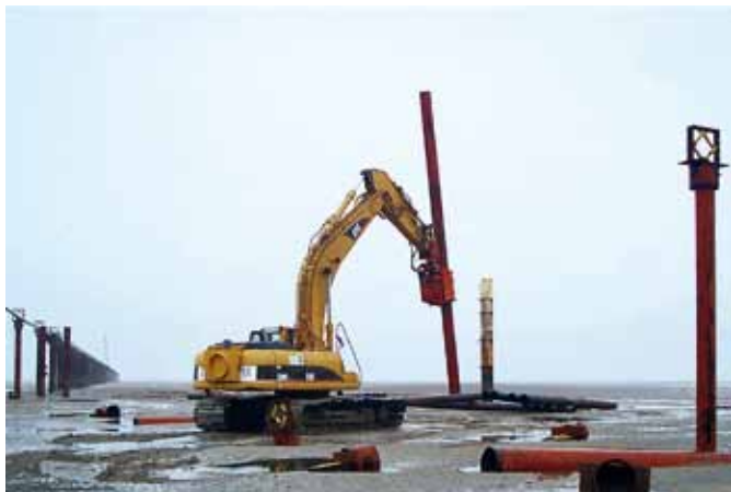
Wbijanie kilkunastometrowych elementów
