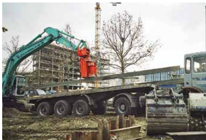
Zdejmowanie elementu z samochodu, przy użyciu wibromłota Movax
