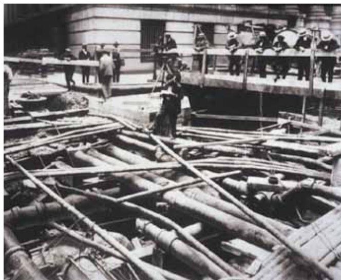
Ryc. 1. Niezintegrowana infrastruktura podziemna
