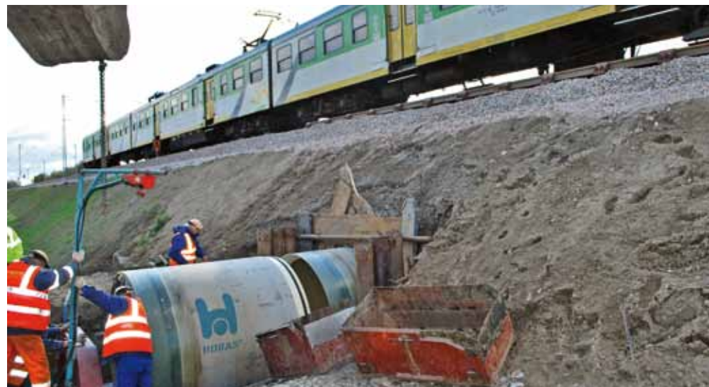
Przepust OD 2047, E65 LCS Ciechanów, odcinek Gąsocin – Ciechanów
