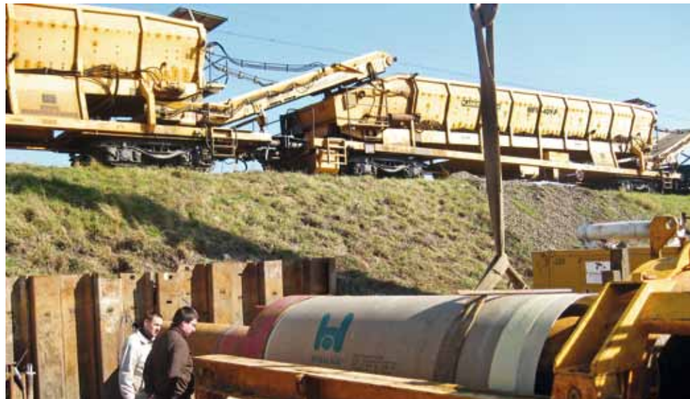
Przepust OD 1280, E65 LCS Działdowo odcinek Gralewo - Rybno
