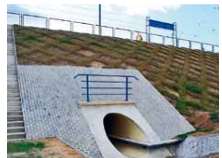
Przepust OD 1720, LCS Ciechanów, odcinek Świercze – Gąsocin
