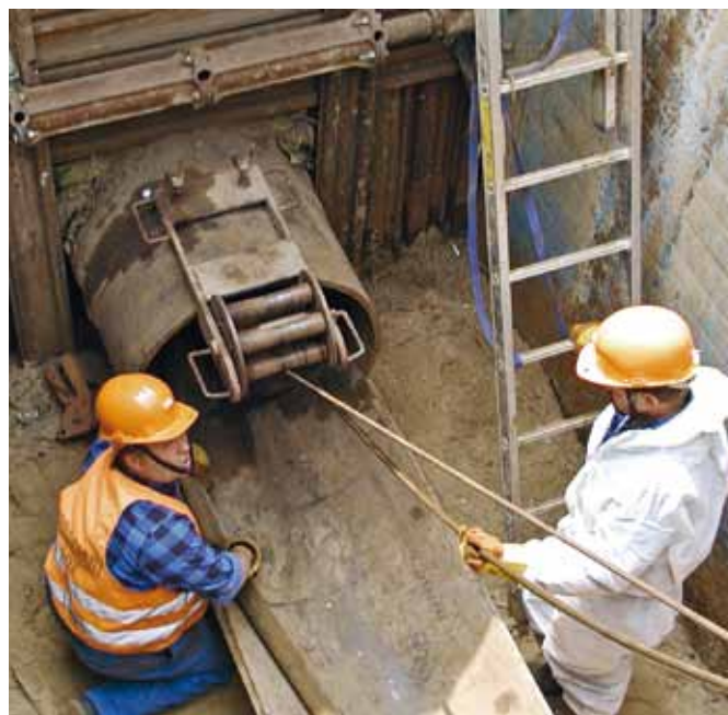
W wykopie podczas cementowania
