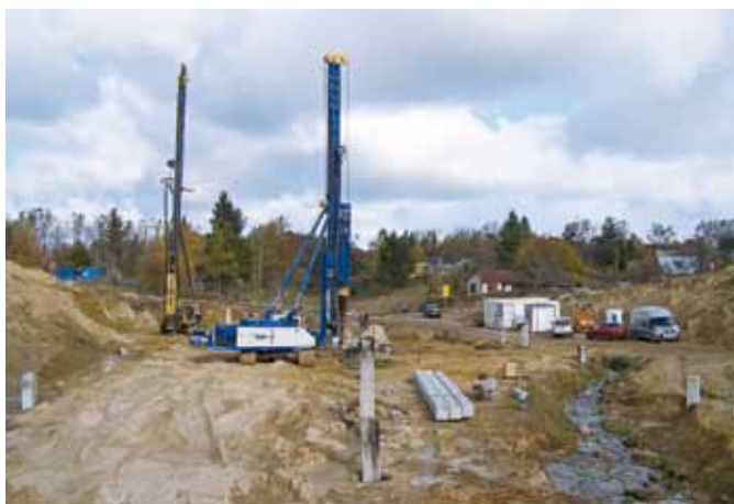
Ryc. 3. Roboty palowe przy obiekcie PG-4
