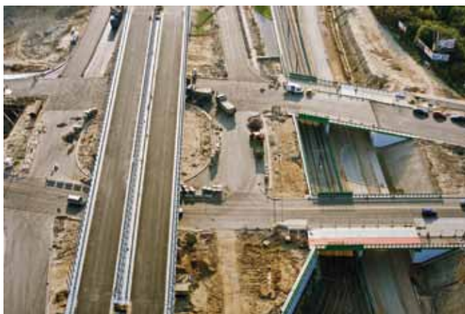
Trasa mostu Północnego w trakcie budowy
