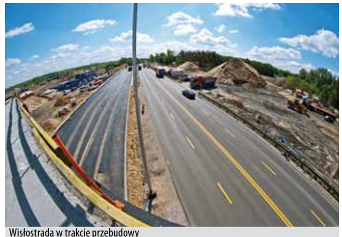
Wisłastrada w trakcie przebudowy
