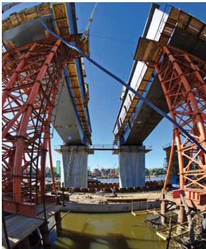
Montaż konstrukcji stalowej na podporach nurtowych mostu przez Wisłę
