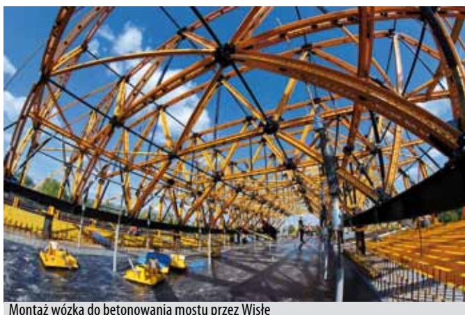
Montaż wózka do betonowania mostu przez Wisłę
