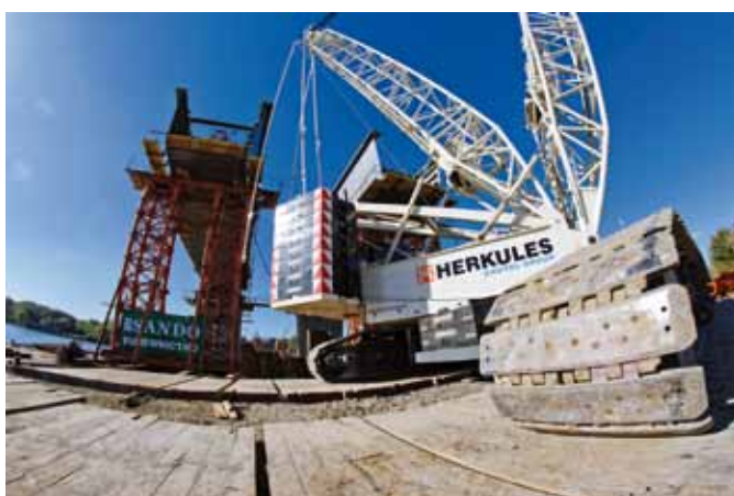
Montaż konstrukcji stalowej na podporach nurtowych mostu przez Wisłę
