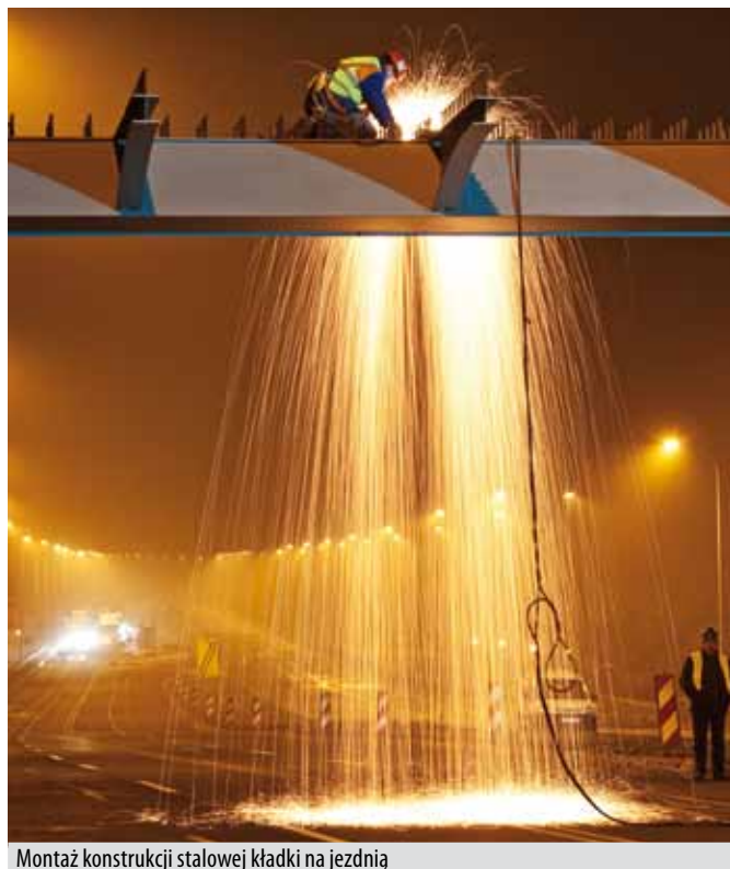
Montaż konstrukcji stalowej kładki na jezdnię
