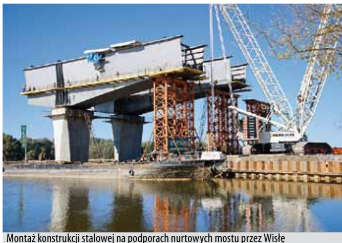
Montaż konstrukcji stalowej na podporach nurtowych mostu przez Wisłę
