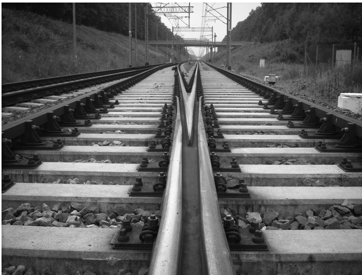
Fot. 2. Krzyżownica w rozjeździe zwyczajnym nr 27 na stacji Korytów
