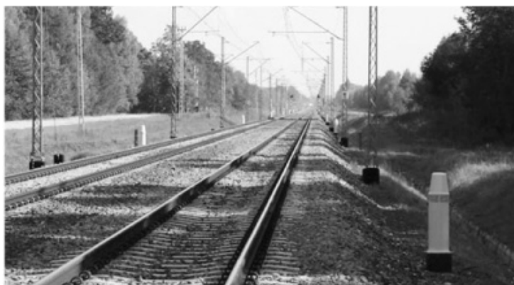
Rys. 1. Widok fragmentu magistrali E-20 Mińsk Mazowiecki-Siedlce z zainstalowanymi prewenterami UOZ-1 [3, 14]
