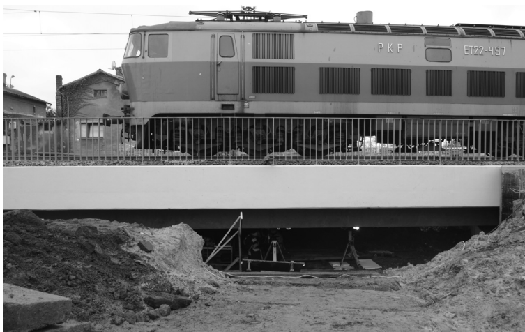
Rys. 3. Pomiary ugięć pod obciążeniem statycznym podczas obciążeń próbnych przęsła w torze nr 2 wiaduktu w Pszczynie
