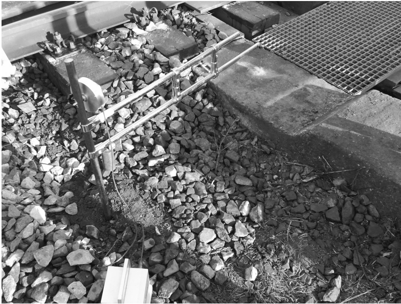
Rys. 16. Test przyrządu zamocowanego do pręta wbitego w podtorze
