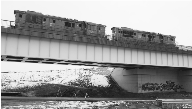
Rys. 6. Wiadukt nad autostradą podczas obciążeń próbnych przęśła nr 1 w torze nr 2
