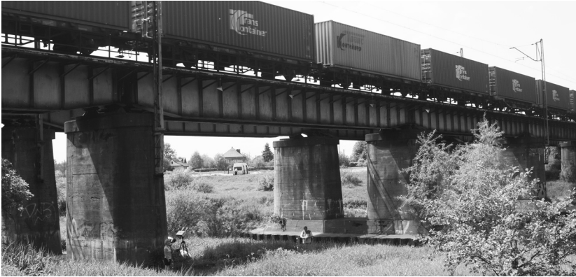
Rys. 8. Pomiary ugięć od obciążeń dynamicznych – most kolejowy nad rzeką Rabą
