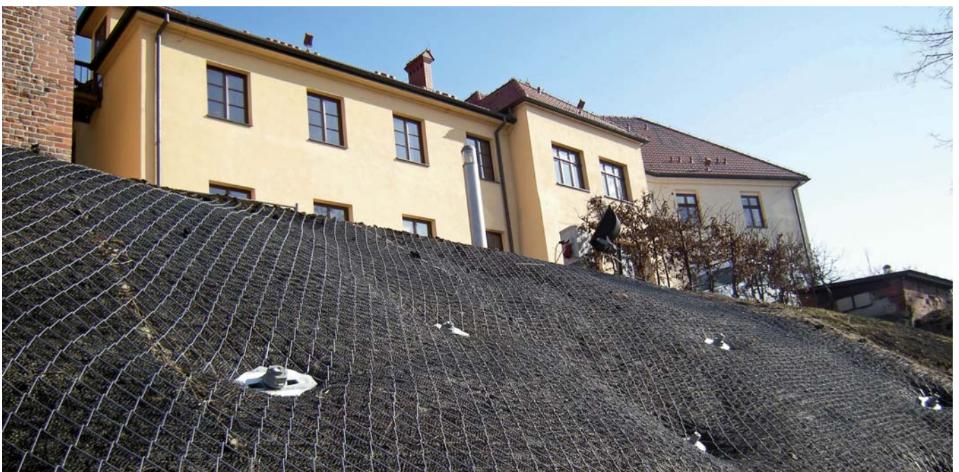
Skarpa po zakończeniu robót
