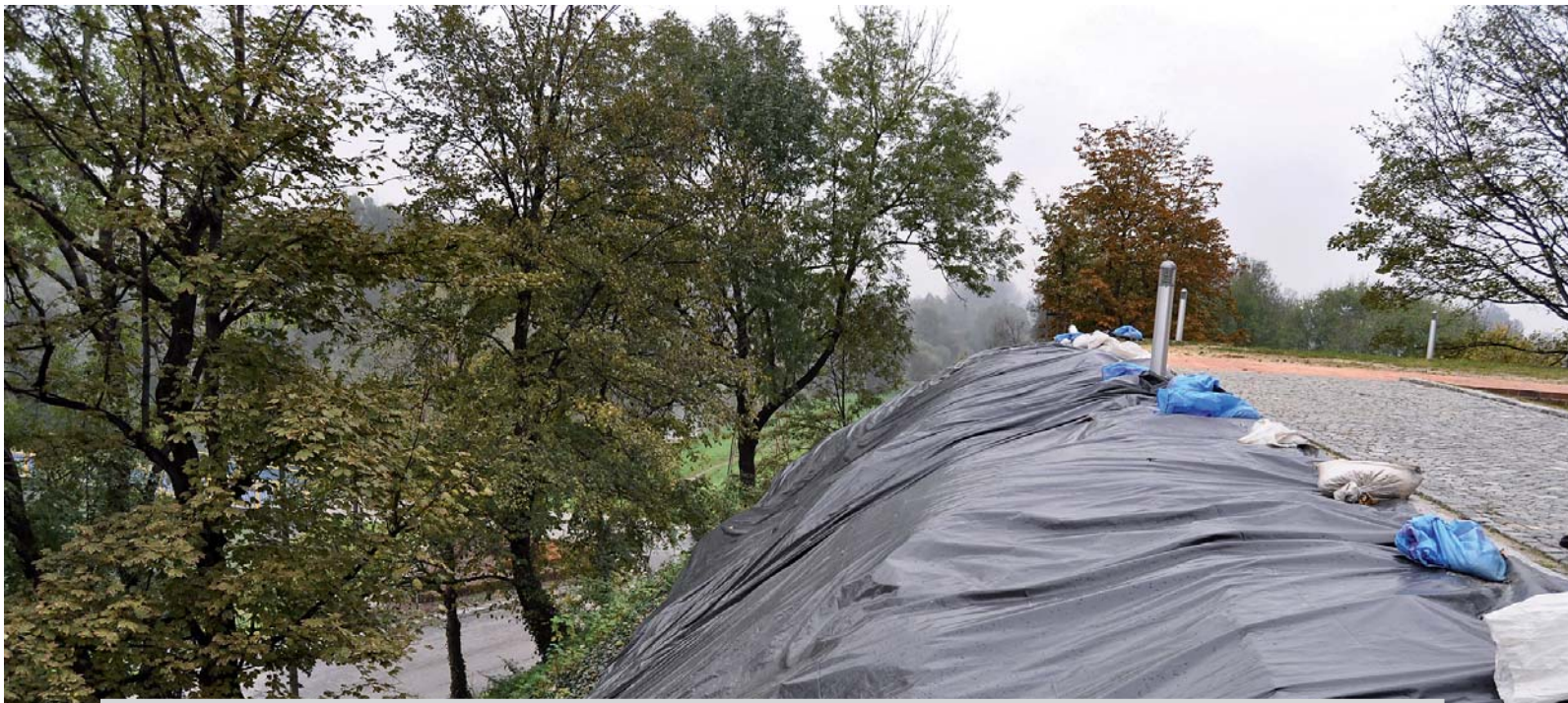
Tymczasowe zabezpieczenie skarpy
