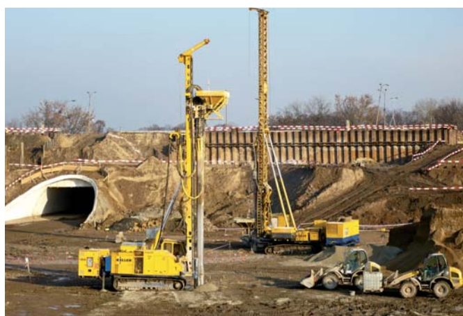
Ryc. 2. Wykonywanie kolumn żwirowych KSS i żwirowo-betonowych FSS pod płytą stadionu [8]
