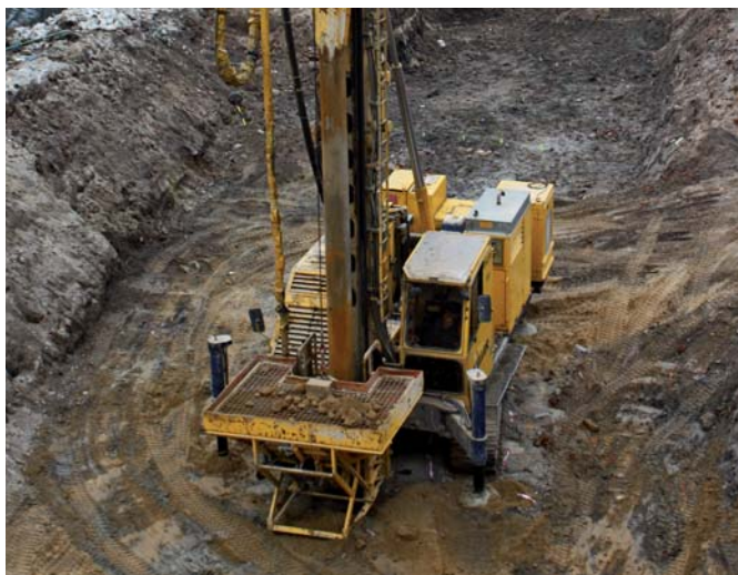
Ryc. 9. Wykonywanie kolumn żwirowych – RZ3
