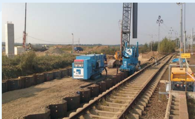
Autostradowa Obwodnica Wrocławia - ścianka szczelna wciskana przy torowisku
