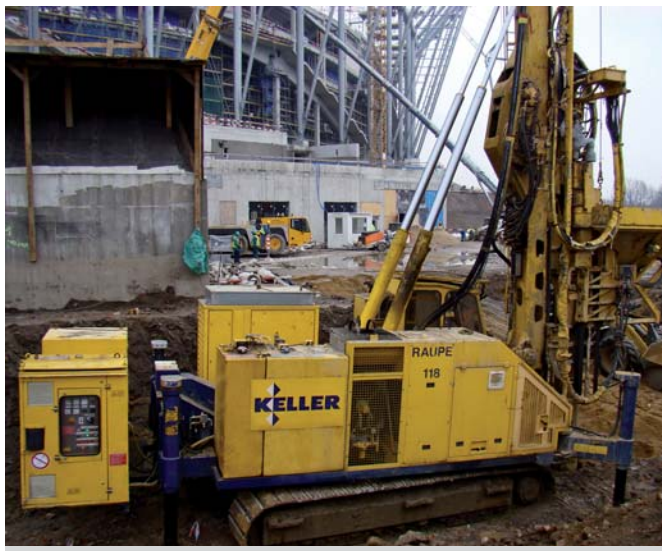
Ryc. 10. Wykonywanie kolumn żwirowych pod fundamenty muru oporowego – MP1
