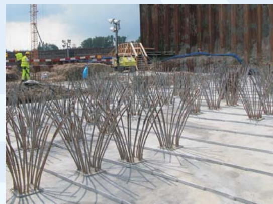
Pale prefabrykowane pod fundamenty Stadionu Narodowego
