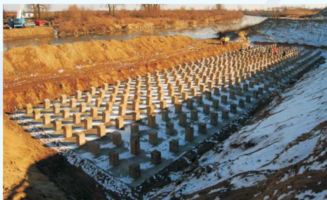
Budowa autostrady A4 odcinek Radymno-Korczowa
