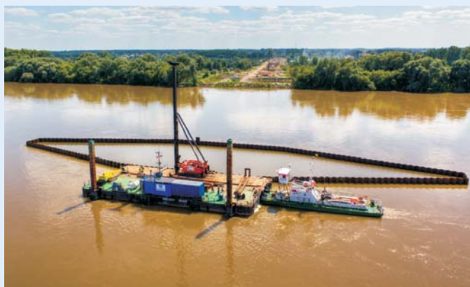
Budowa mostu przez Wisłę w Toruniu
