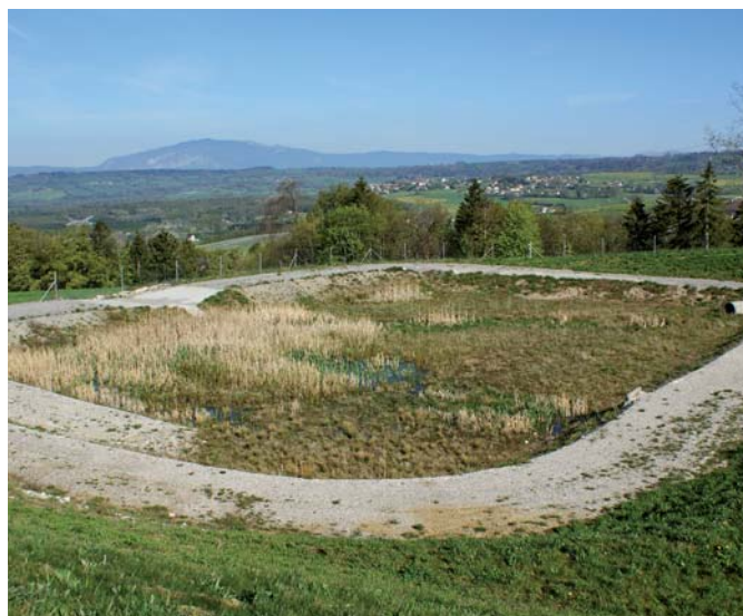
Zbiornik infiltracyjny wód opadowych w Cruseilles (Francja), fot. D. Słyś
