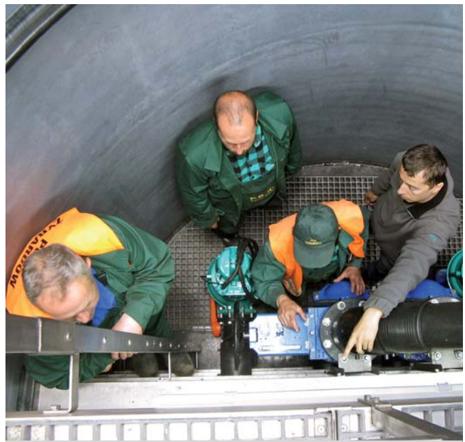
Najniższy poziom w studni – ustawienie suchej pompy
