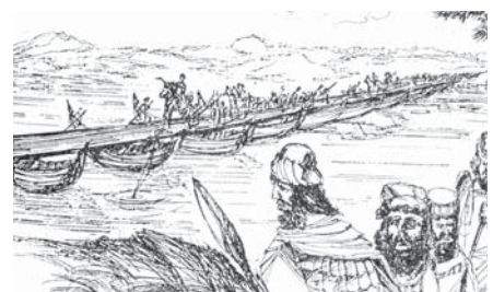
Ryc. 5. Mandrokles z Samos, most pontonowy (tyżwowy) przez Bosfor, 512 p.n.e., l = 900 \text{ m} [4]
