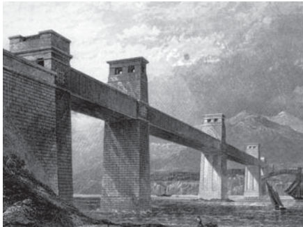
Ryc. 27. Robert Stephenson, Britannia Bridge przez cieśninę Menai w Walii, 1850, l_{max} = 141,73 m [2]
