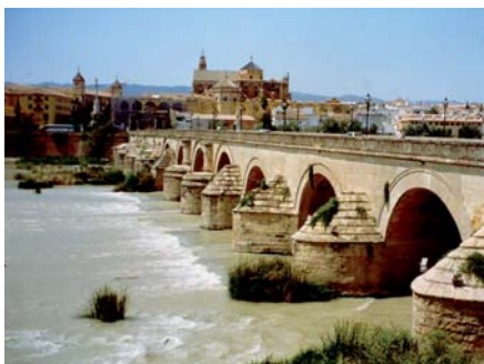
Ryc. 7. Gajus Julius Cezar, wieloprzęsłowy most łukowy przez Gwadalkiwir w Kordowie, 61 p.n.e. [2]
