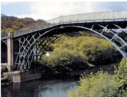
Ryc. 22. Abraham Darby III i Joseph Wilkinson, Iron Bridge przez Severn w Coalbrookdale w Anglii, 1771–1779, l = 30,5 m [2]
