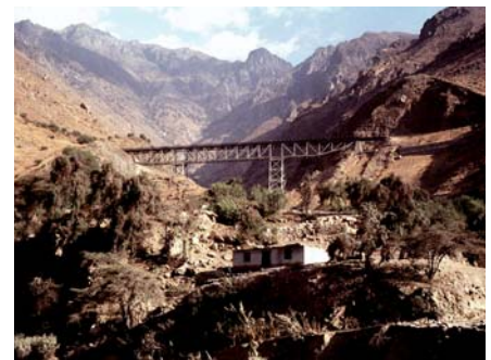
Ryc. 33. Linia kolejowa przez Andy Peruwiańskie (4784 m n.p.m.) z Limy do La Oroya [6]
