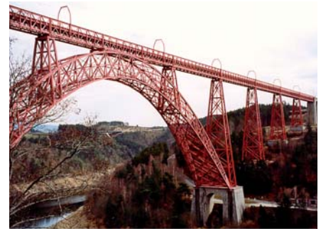
Ryc. 31. Gustave Eiffel, wiadukt Garabit nad rzeką Truyère w południowej Francji, 1880–1884, l_{max} = 165,0 m [2]
