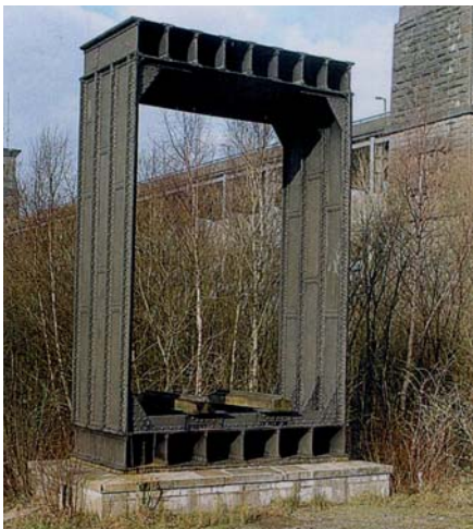
Ryc. 28. Britannia Bridge, element nitowanej belki przęsłowej [2, 6]
