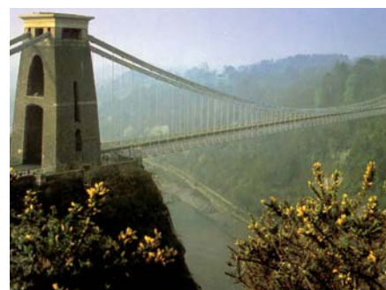
Ryc. 25. Isambard Brunel, łańcuchowy most wiszący Clifton przez wąwóz rzeki Avon w południowej Anglii, 1831–1864, l = 214,0 m [2]
