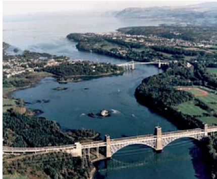
Ryc. 29. Britannia Bridge, stan obecny, most odbudowany po pożarze [6]
