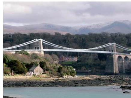
Ryc. 24. Thomas Telford, łańcuchowy most wiszący przez cieśninę Menai w Walii, 1819–1826, l_{\max} = 176,5 m [6]
