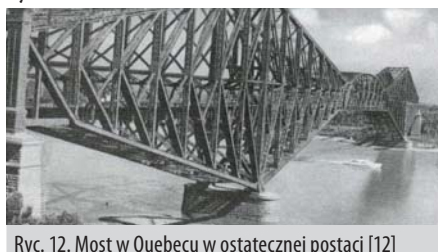
Ryc. 12. Most w Quebecu w ostatecznej postaci [12]
