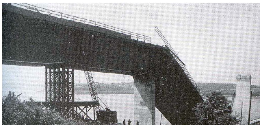
Ryc. 19. Most Cleddau po katastrofie [13]
