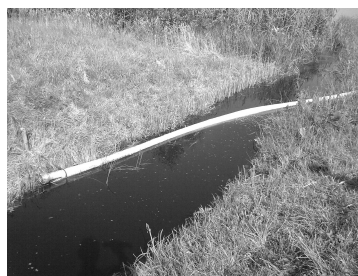
Fot. 6. i 6a. Akcja ratownicza na doprowadzalniku siedleckiego zalewu – zatrzymanie wpłyńnięcia zanieczyszczeń do akwenu.
