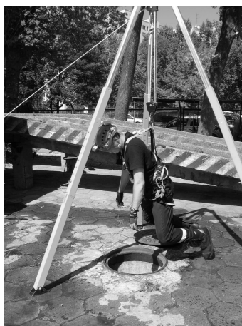
Ryc. 14. Pozycja ratownika w uprzęży przemysłowej z punktem wpięcia na plecach
