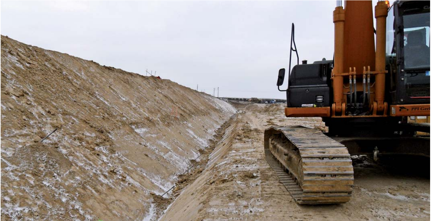
Ryc. 2. Zabezpieczona skarpa przez gwoździowanie w km 646 + 140–646 + 400
