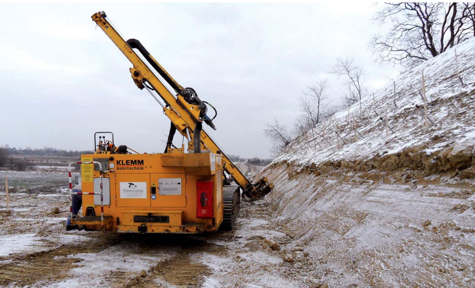
Ryc. 1. Zabezpieczanie skarpy przez gwoździowanie w km 646 + 140–646 + 400
