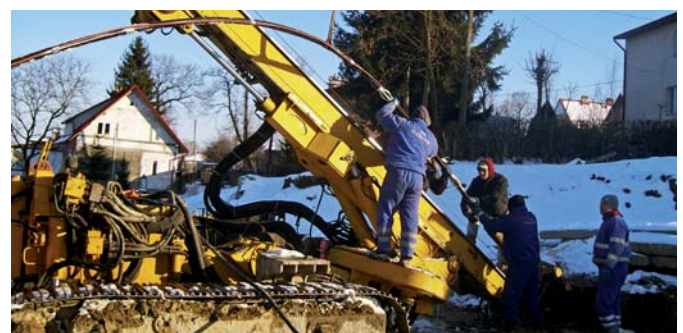
Ryc. 6. Montaż kotew prętowych
