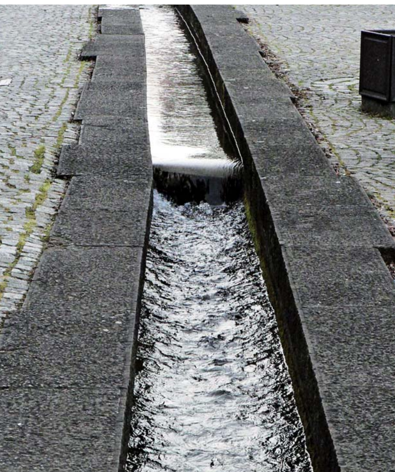
Koryto odwodnieniowe w ciągu komunikacyjnym
