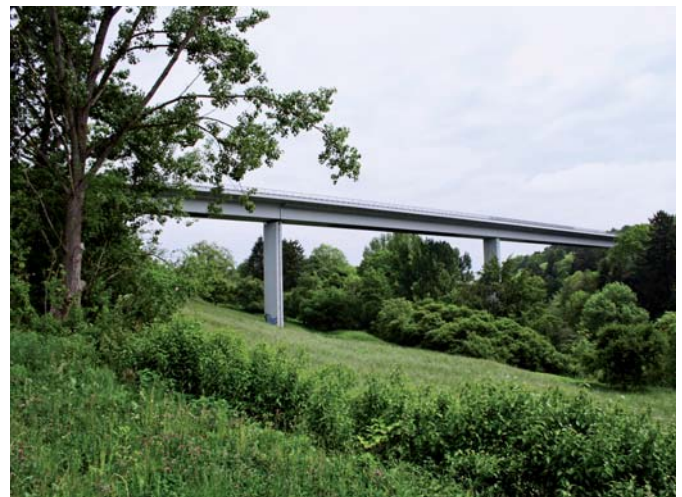
Przejście dolne duże – estakada (autostrada A98, Niemcy), fot. R. Kurek
