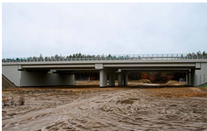
Przejście dolne dla dużych zwierząt – w trakcie budowy (droga ekspresowa S3), fot. R. Kurek
