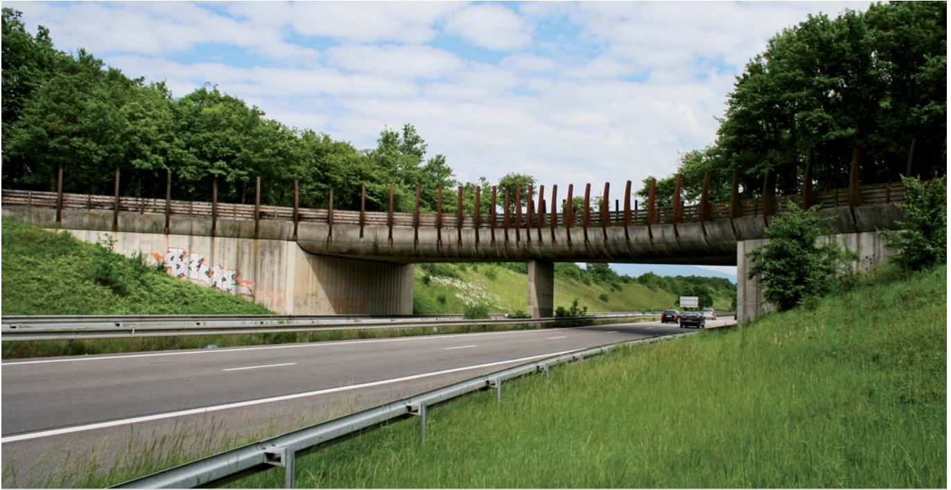
Przejście górne dla średnich zwierząt (autostrada A36, Francja), fot. R. Kurek
