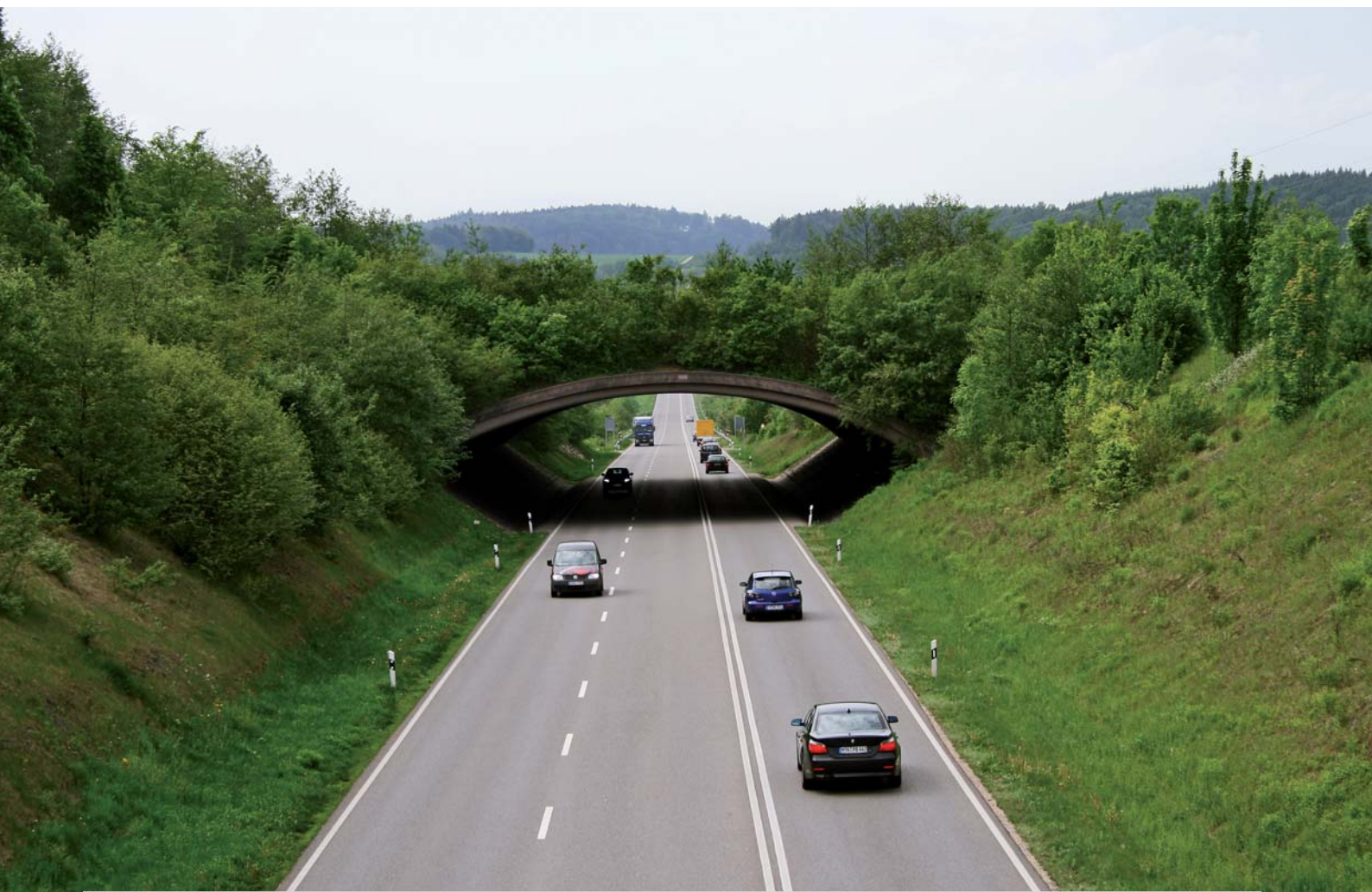
Optymalna lokalizacja przejścia górnego – wykop umożliwiający właściwe wkomponowanie obiektu w otoczenie (droga B31neu, Niemcy), fot. R. Kurek
