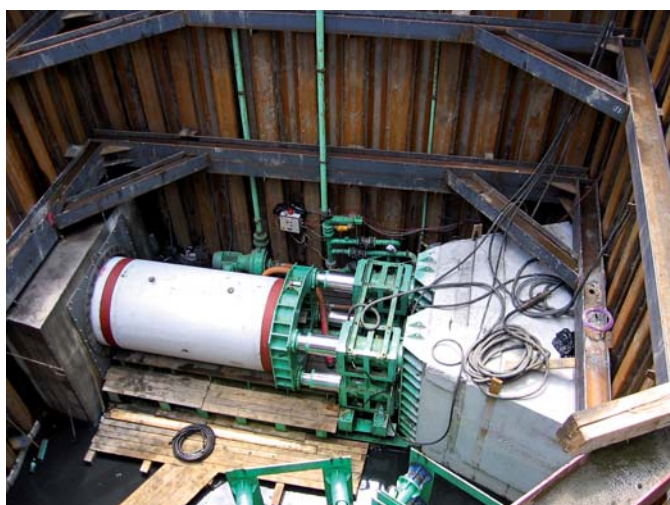
Kolektor w ul. Sierszewskiego – komora z maszyną do mikrotunelingu
