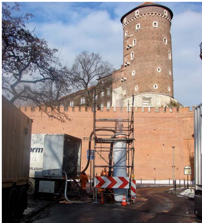
Renowacja kanału za pomocą rękawa termoutwardzalnego
