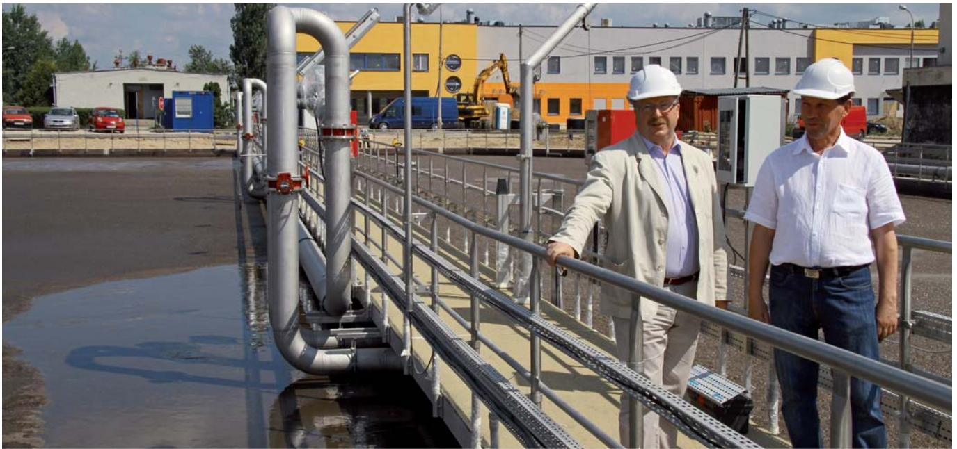
Oczyszczalnia Ścieków Sitkówka” modernizowana i rozbudowana. Projekt współfinansowany z Funduszu Spójności
