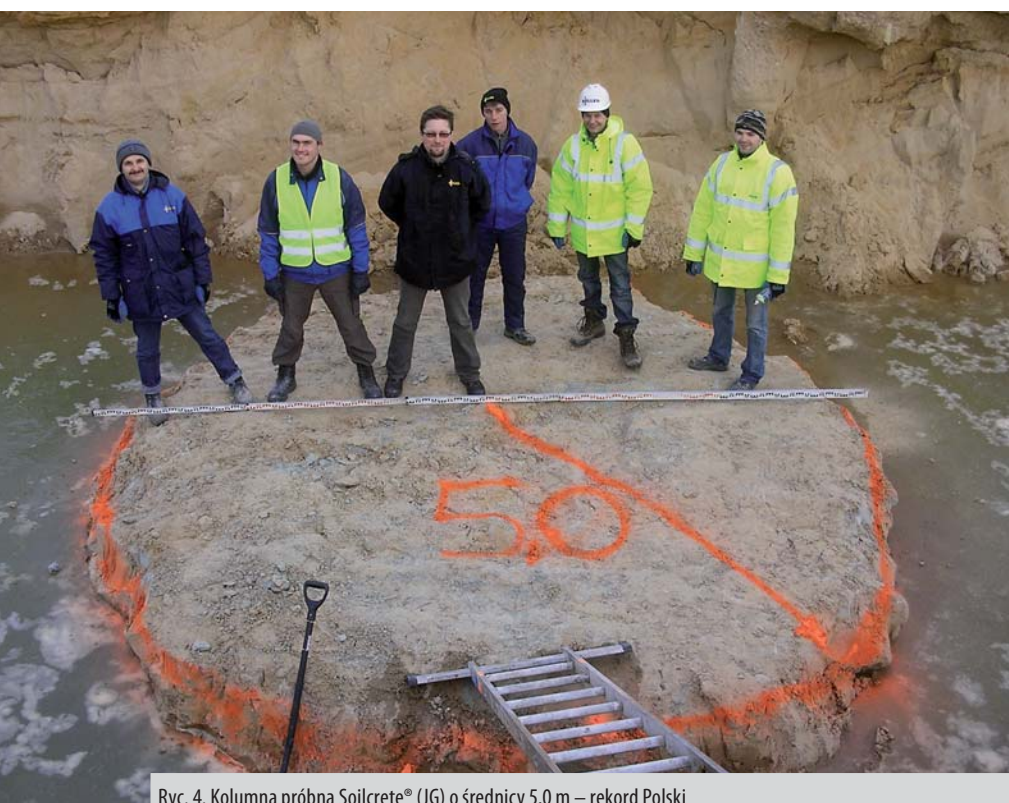
Ryc. 4. Kolumna próbna Soilcrete® (JG) o średnicy 5,0 m – rekord Polski
