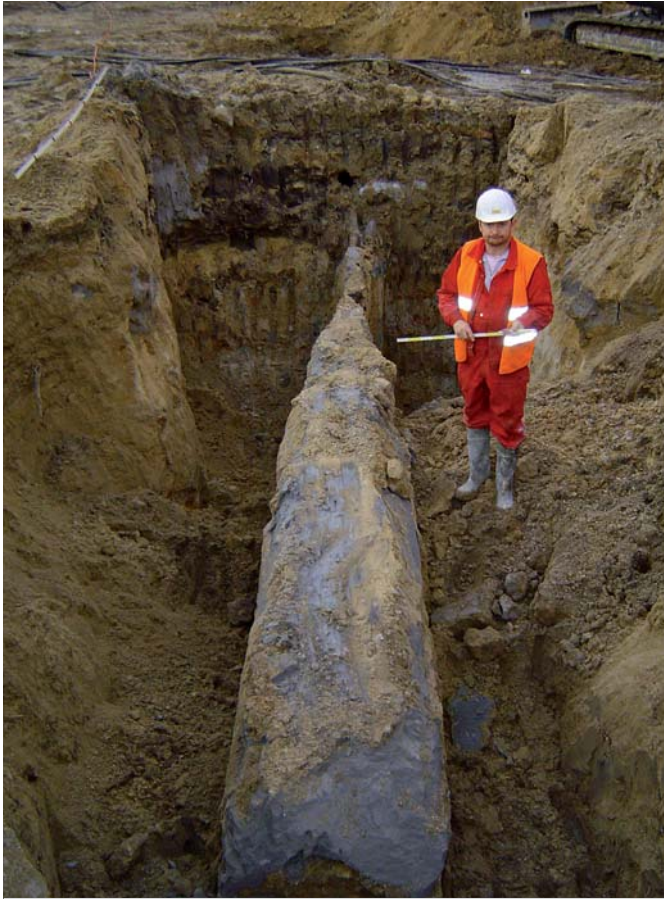
Ryc. 5. Widok odkopanej przesłony pionowej w postaci pojedynczej lameli Soilcrete® (jet grouting)
