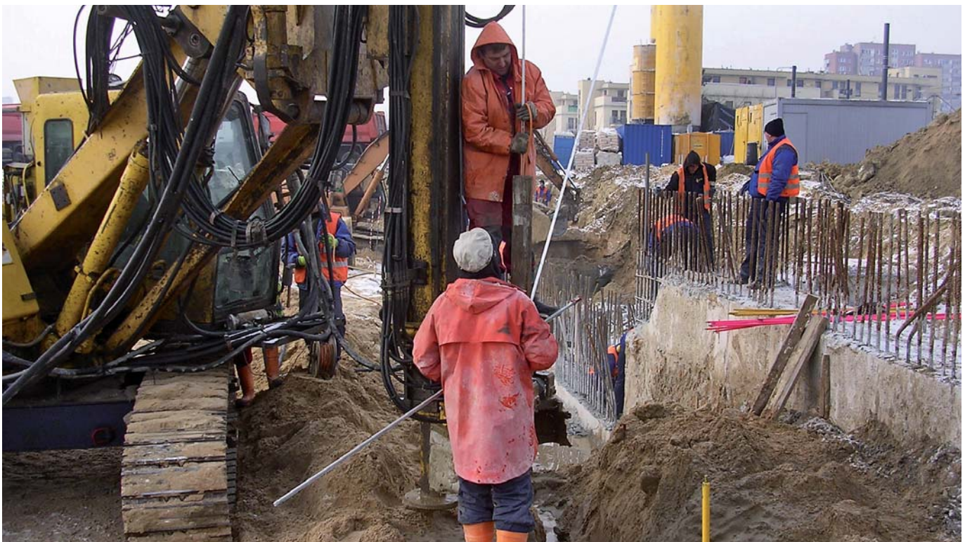
Ryc. 6. Pomiar inklinometrem pionowości odwiertu oraz kierunku i wielkości odchyłki
