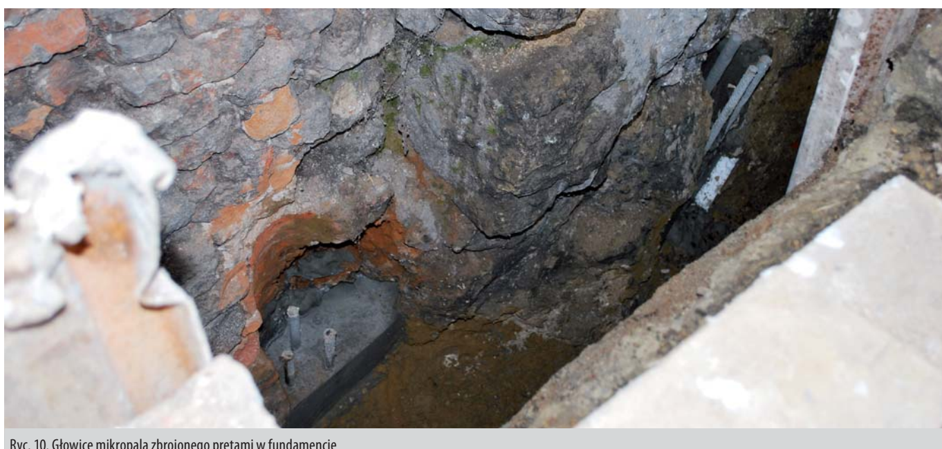
Ryc. 10. Głowice mikropala zbrojonego prętkami w fundamencie
