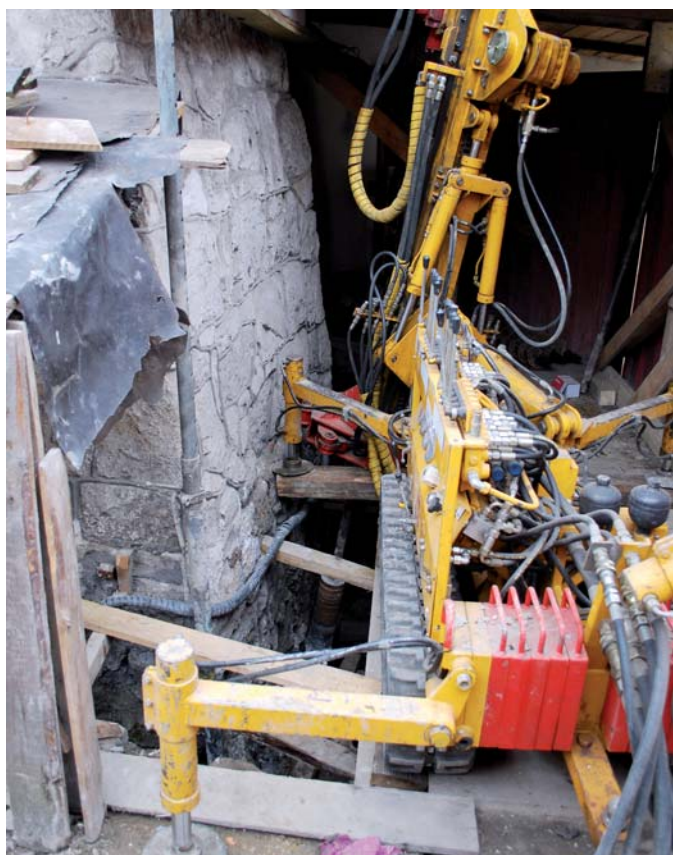
Ryc. 9. Wzmacnianie fundamentów mikropalami
