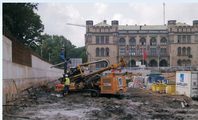
Narodowe Forum Muzyki Wrocław - kotwienie ściany szczelinowej
