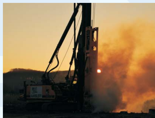
Południowa Obwodnica Gdańska - pale prefabrykowane wbijane pod fundamenty najdłuższej estakady w Polsce
