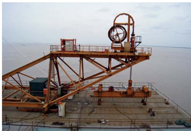
Urządzenie do podnoszenia segmentów pomostu, źródło: DLT
