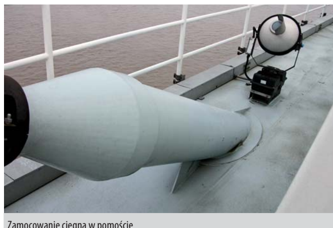
Zamocowanie cięgna w pomoście
