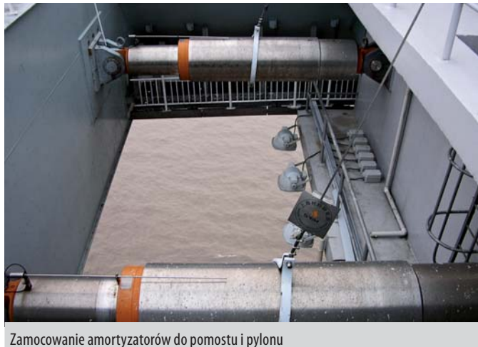
Zamocowanie amortyzatorów do pomostu i pylonu
