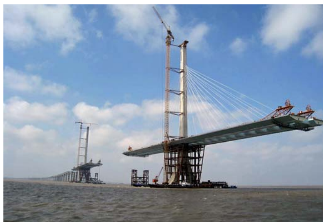
Montaż sekcji pomostu, źródło: DLT
