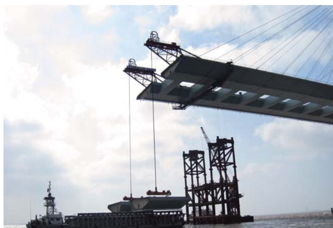
Montaż segmentów pomostu, źródło: DLT
