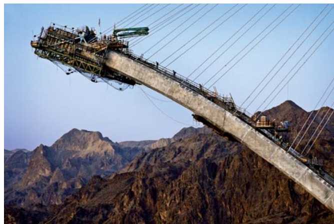
Wznoszenie łuków od strony stanu Arizona, fot. J. Stillings
