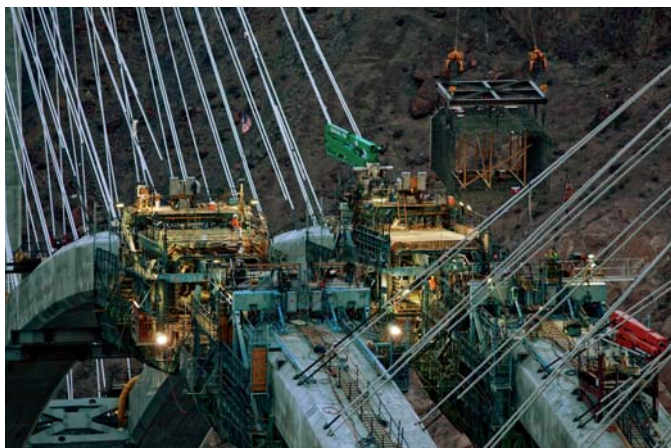
Prace przy zamykaniu łuków mostu, fot. J. Stillings
