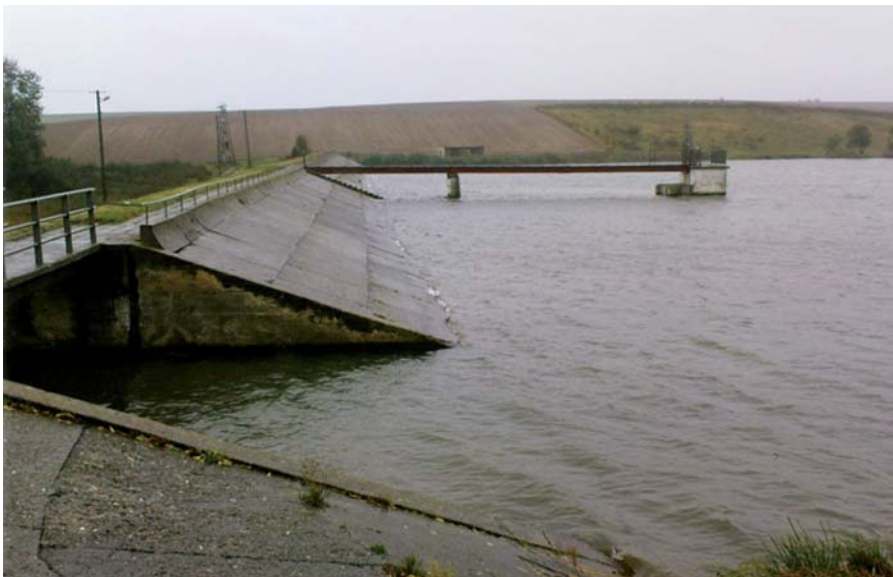
Ryc. 3. Niewielki obiekt piętrzący tzw. małej retencji
