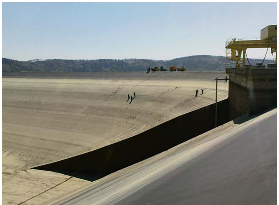
Czasza zbiornika górnego elektrowni szczytowo-pompowej w trakcie okresowego przeglądu
