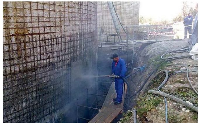
Naprawa zewnętrznych powierzchni zbiorników. Nanoszenie zaprawy natryskowej zawierającej mikrokrzemionkę, fot. www.otik.pl
