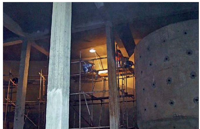
Natryskiwanie zapraw naprawczych na strop i ściany wewnętrzne, fot. www.otik.pl
