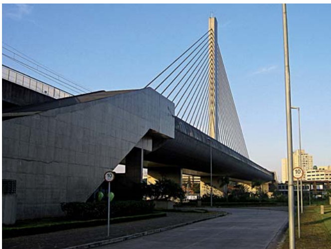
Ryc. 3. Stacja Santo Amaro na linii 5 Lilás
