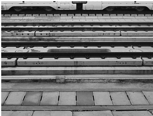
Rys. 5. Nawierzchnia bezpodсыpkowa na linii KDP Nankin – Szanghaj
