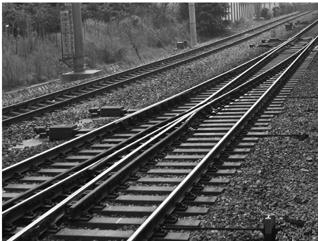
Rys. 4. Rozjazd z ruchomą krzyżownicą na zmodernizowanym odcinku linii konwencjonalnej Nankin – Szanghaj
