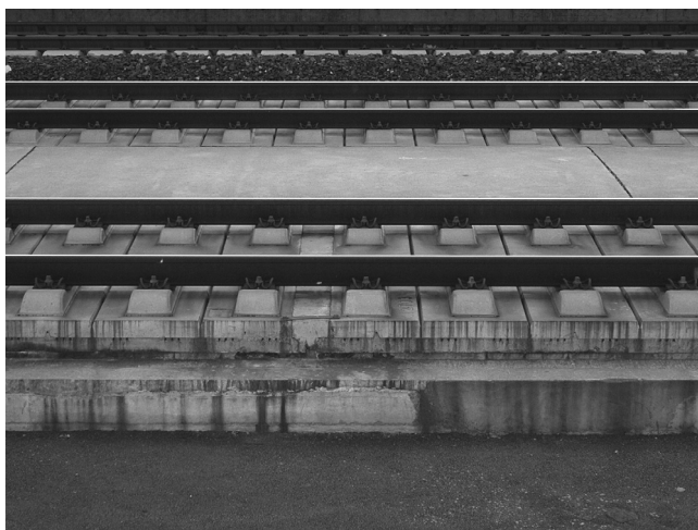
Rys. 6. Nawierzchnia Max Bögl na linii Pekin – Tianjin
