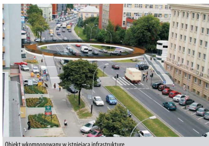
Obiekt wkomponowany w istniejącą infrastrukturę
