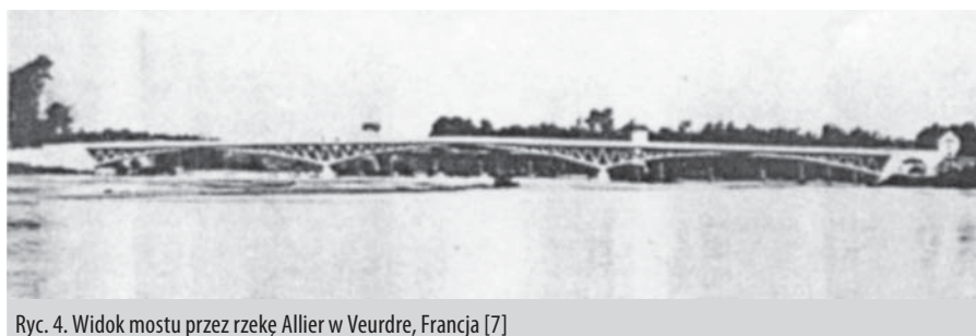
Ryc. 4. Widok mostu przez rzekę Allier w Veudre, Francja [7]
